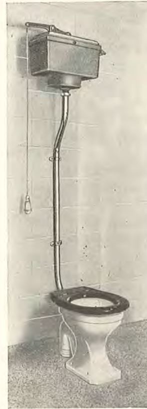
Fig. 130. Normal W. C.-Installation med Skyلlecisterne.
