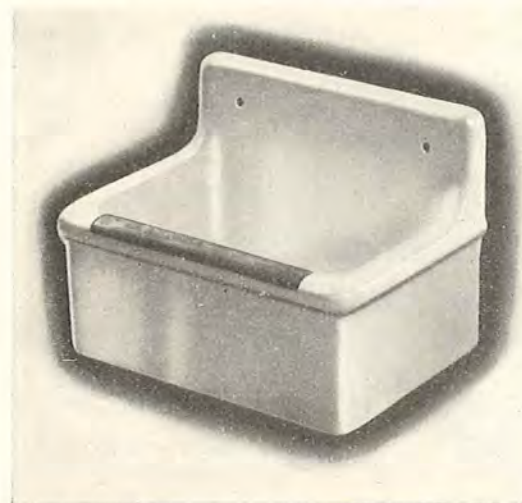
Fig. 113. Udslagningsvask med Træliste paa Forkanten.
