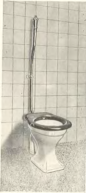
Fig. 131. W. C.-Installation med Skyллеventil.
